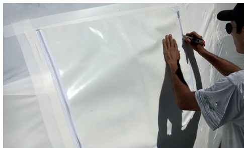
Schrumpfverpackung mit Serviceklappe (Reissverschluss).
