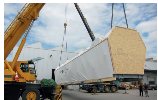
Holzgerippe mit LKW-Blache bespannt.
