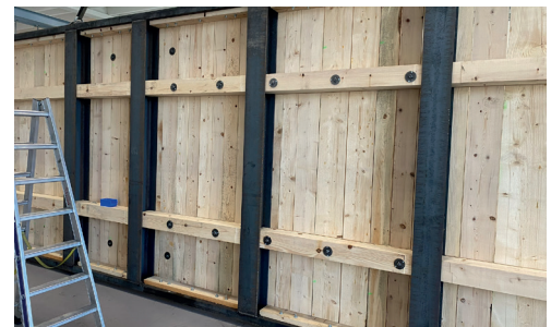
Holzboden mit Stahlträger für schwere und hohe Maschine.
